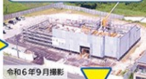
2階部分の基礎工事開始
