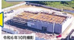
2階部分の基礎工事完了
