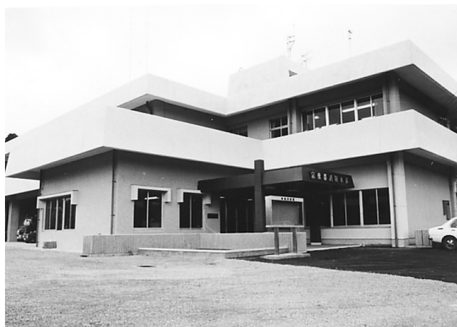
▲完成した消防庁舎（昭和49年）
