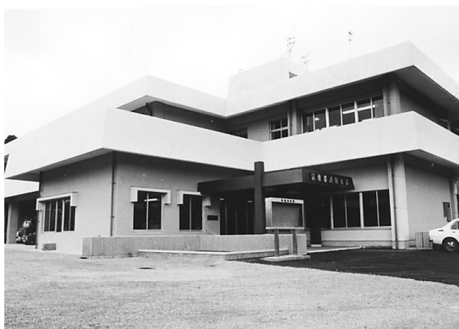
▲完成した消防庁舎（昭和49年）
