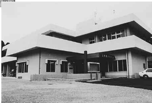
完成した消防庁舎▶ (昭和49年)
