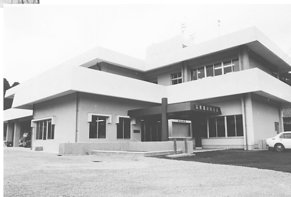
▶完成した消防庁舎 (昭和49年)
