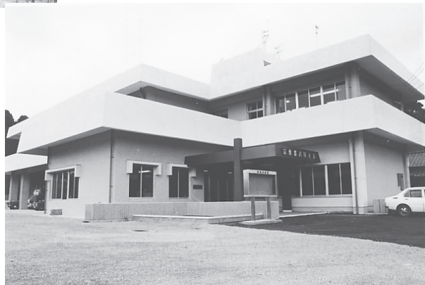
▶ 完成した消防庁舎 (昭和49年)
